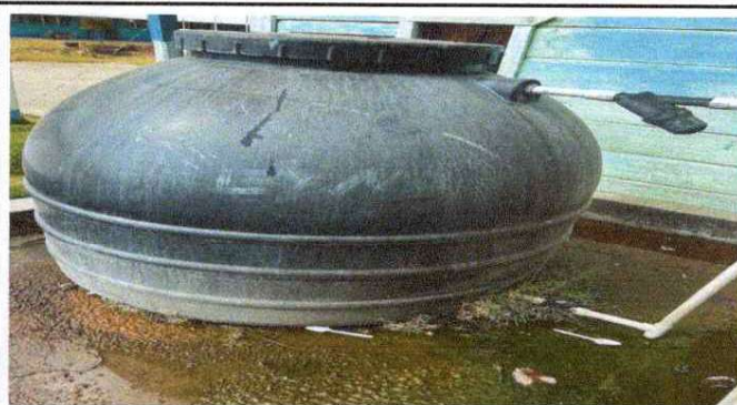
Foto 2: Sustitución de depósito de agua 1700 lt
