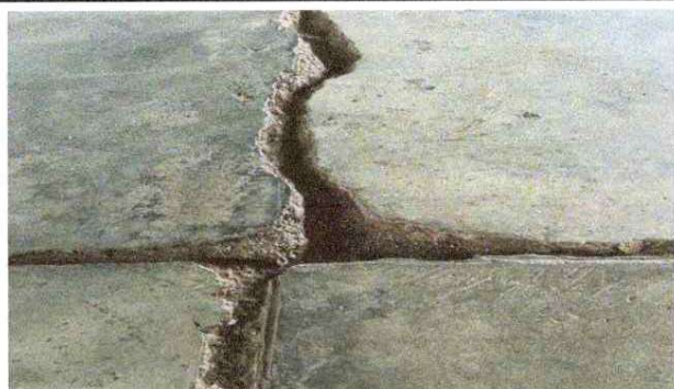
Foto 3: Sustitución de piso de granito y cerámico
