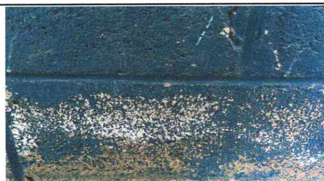
Foto 5: Pintura en muros exteriores e interiores
