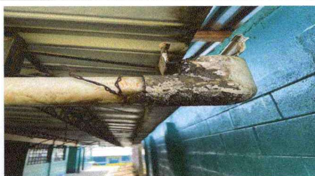
Foto 4: Sustitución de canal Pvc
