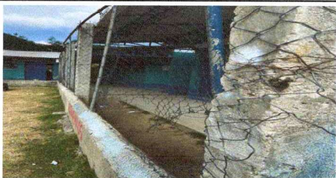
Foto 1: Reparación de muro perimetral de bloques con tubo galvanizado, soleras intermedias y columnas.
