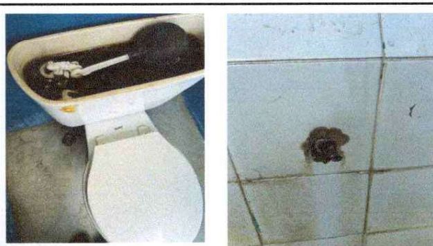
Foto 6: Sustitución de inodoro y de llave de paso
