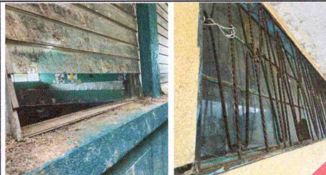
Foto 2: Sustitución de vidrios y mantenimiento de balcones de metal
