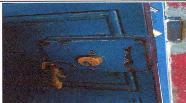
Foto1: Mantenimiento a estructuras, lijado y aplicación de pintura y sustitución de chapa
